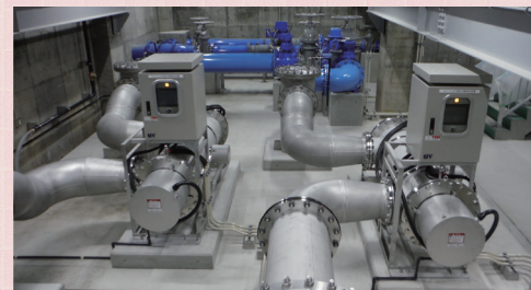
上水道紫外線殺菌装置(茅野市納入)
